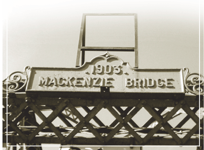
Plaque toponymique au pont Mackenzie. Type Warren à double intersection construit en 1903 sur la rivière Saint-François à Richmond (Estrie) par la Dominion Bridge. IPP de 46.
