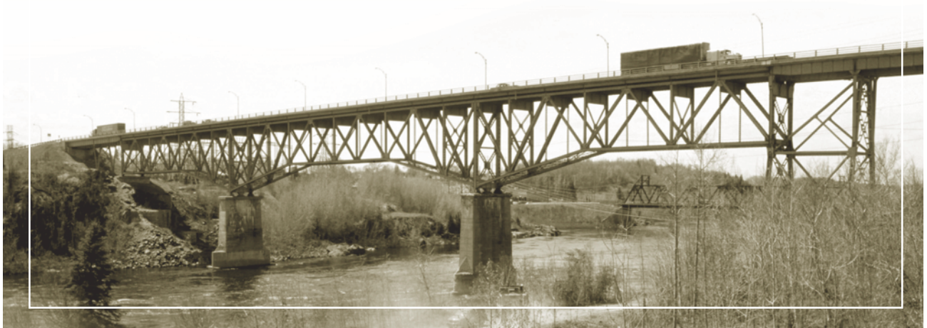
IPP de 25 : Pont Jean-F.-Grenon sur la rivière Grande Décharge à Alma (Saguenay–Lac-Saint-Jean). Type Warren (avec verticales) à corde inférieure polygonale, érigé par encorbellement en 1930 par la Dominion Bridge sur la route 169.
