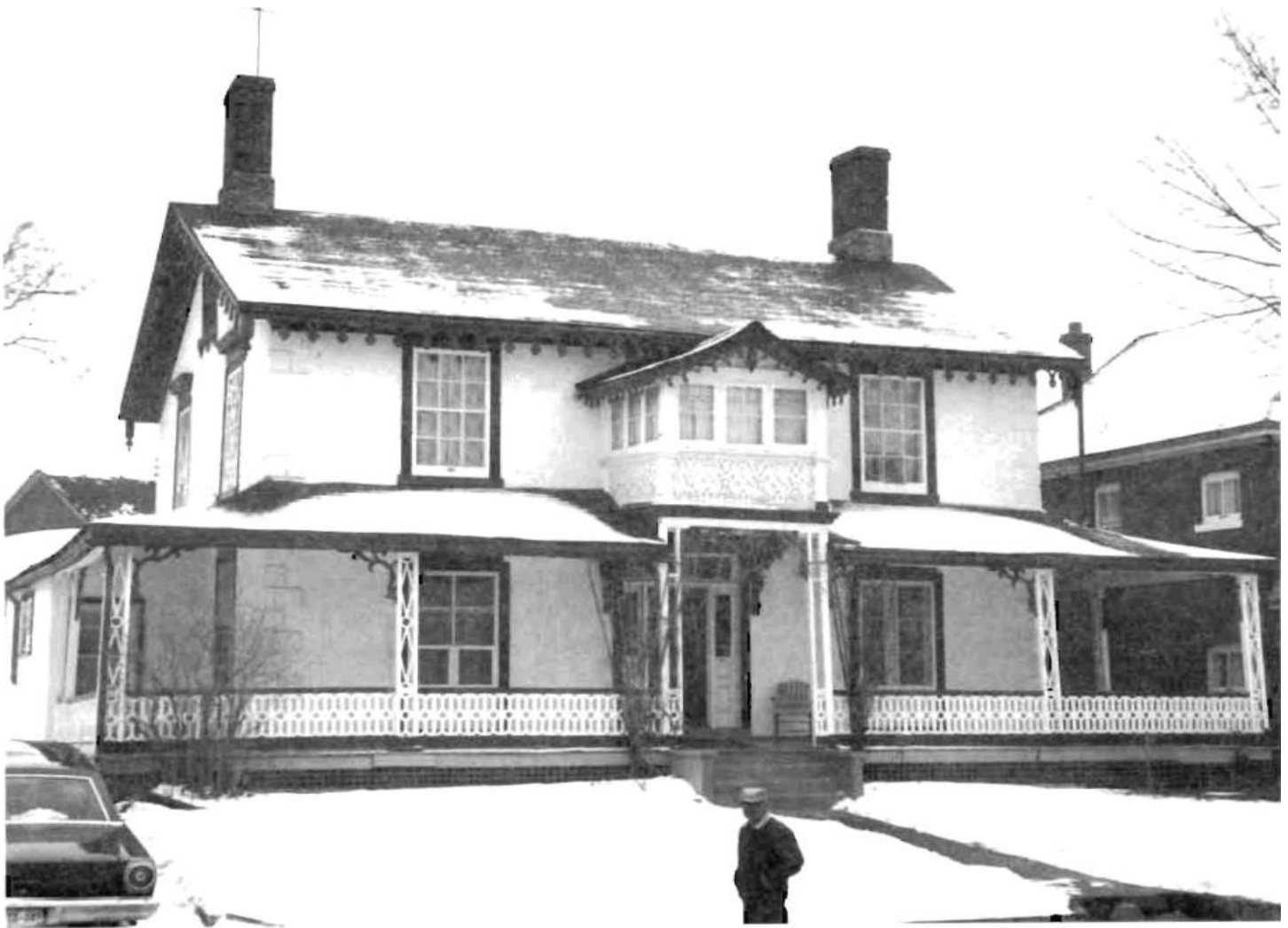
78 Maison 9, rue Bradford, Barrie, Ontario. Construction en 1855; revêtement: stuc.
