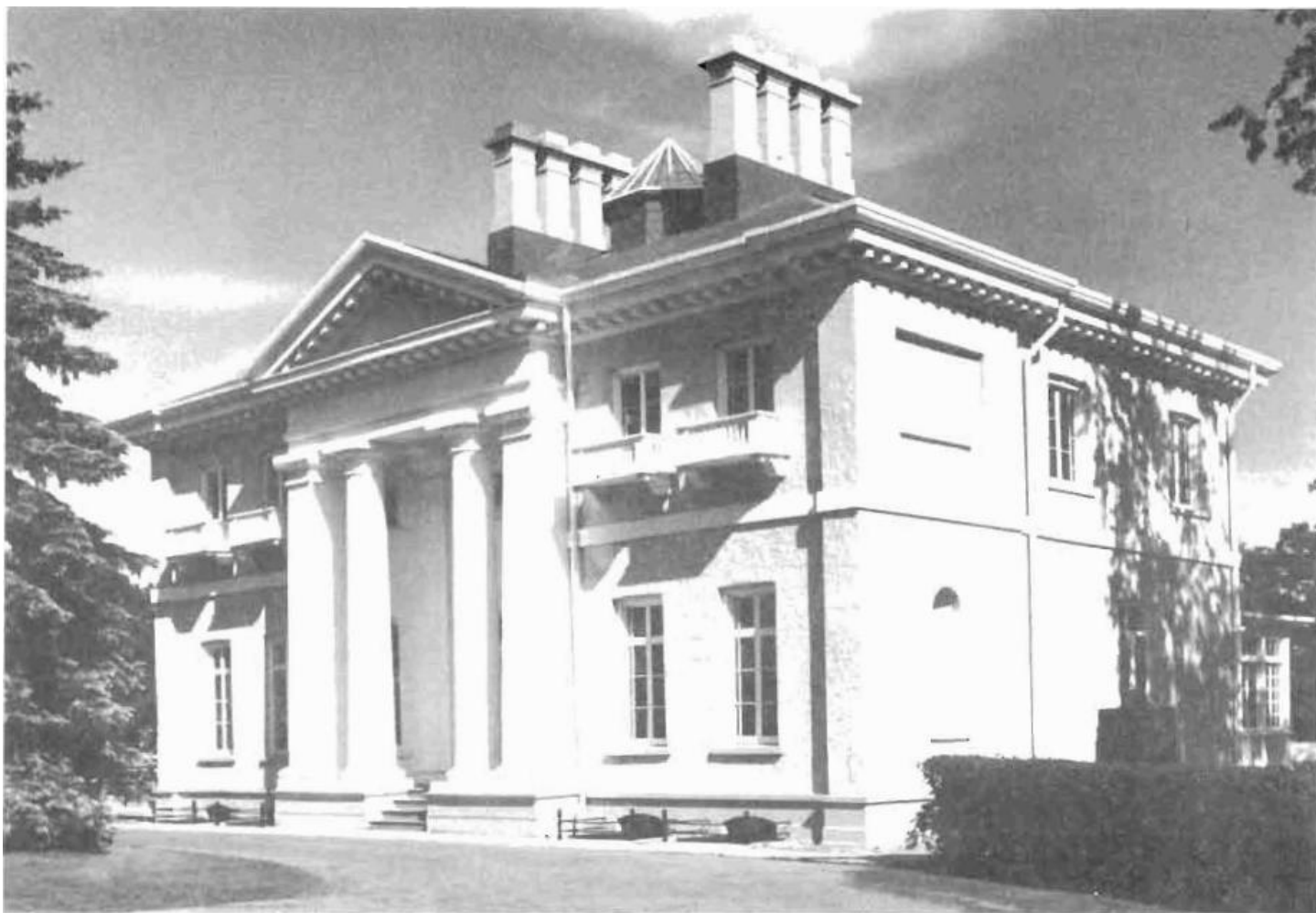
60 Rockwood 740, rue King ouest, Kingston, Ontario. Construction en 1841-1842; George Browne, architecte; revêtement: pierre et stuc.
