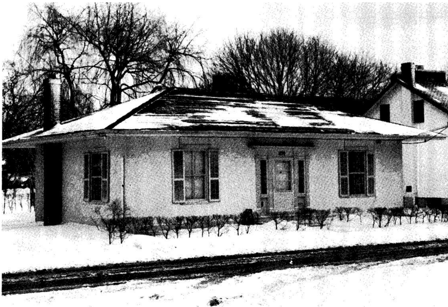
48 Cottage 250, rue Mathew, Cobourg, Ontario. Construction en 1834; revêtement: stuc.
