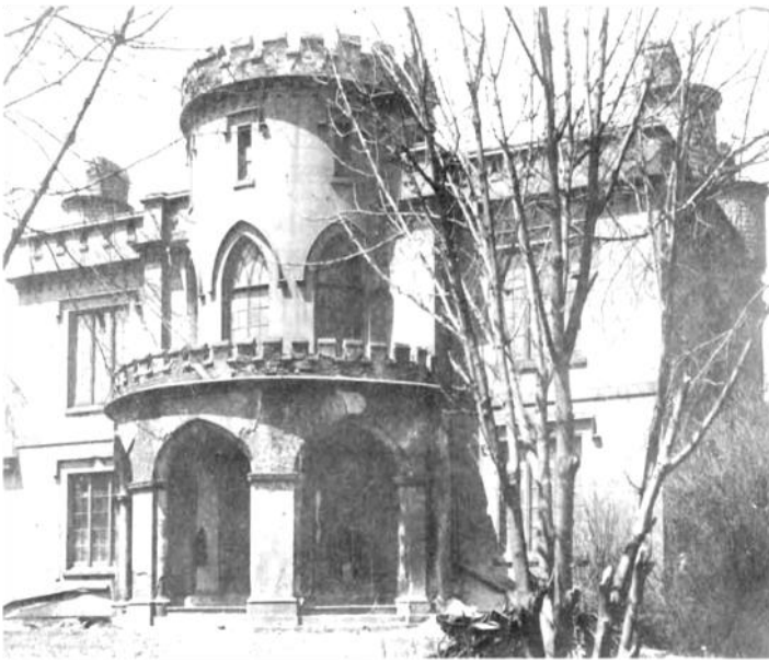
63 61 rue Wellington ouest, Toronto, Ontario. Construction en 1831 (démolie en 1904); revêtement: brique et stuc
