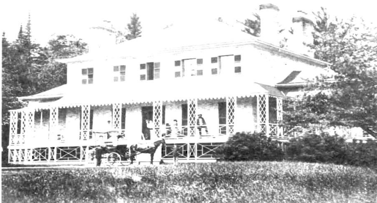
94 Beauvoir en 1865; 2315, chemin Saint-Louis, Sillery, Québec. Construction en 1849; John Cliff, architecte; revêtement: brique jaune.
