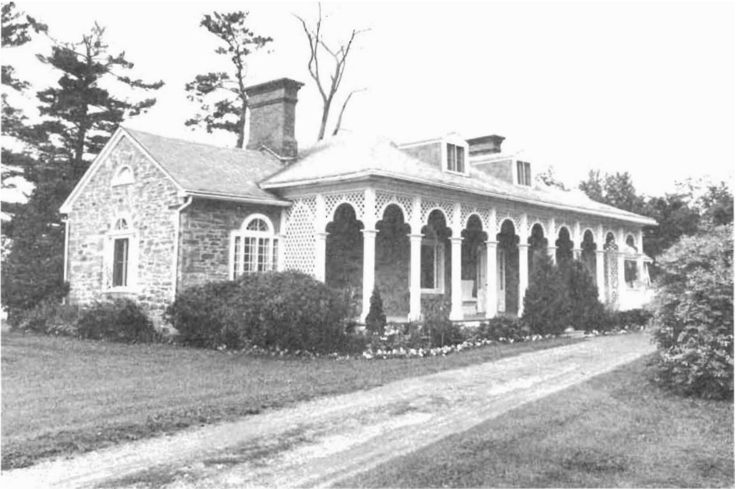
42 Riverest, L'Original, Ontario Construction en 1833; revêtement: pierre.
