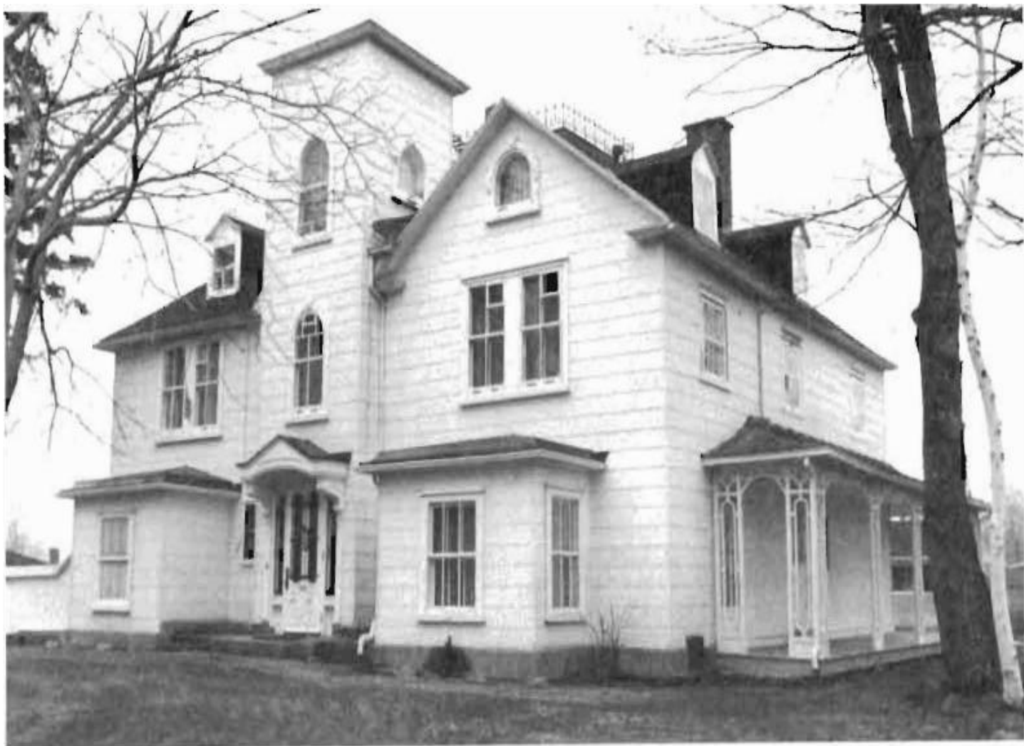
92 Le manoir Spencer, vers 1972; 1321, avenue Lemoine, Sillery, Québec. Construction vers 1844; revêtement: bois
