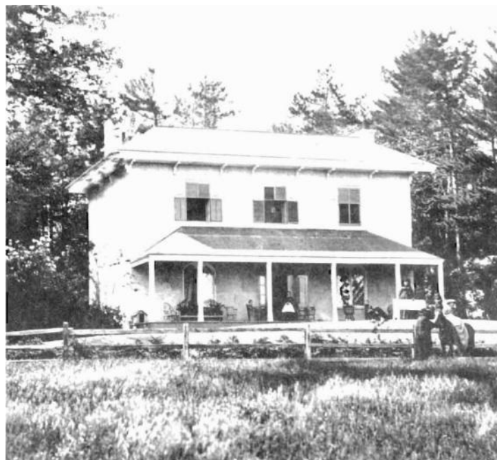
90 Benmore en 1865; 2071, chemin Saint-Louis, Sillery, Québec. Construction en 1834; George Browne, architecte; revêtement: stuc.
