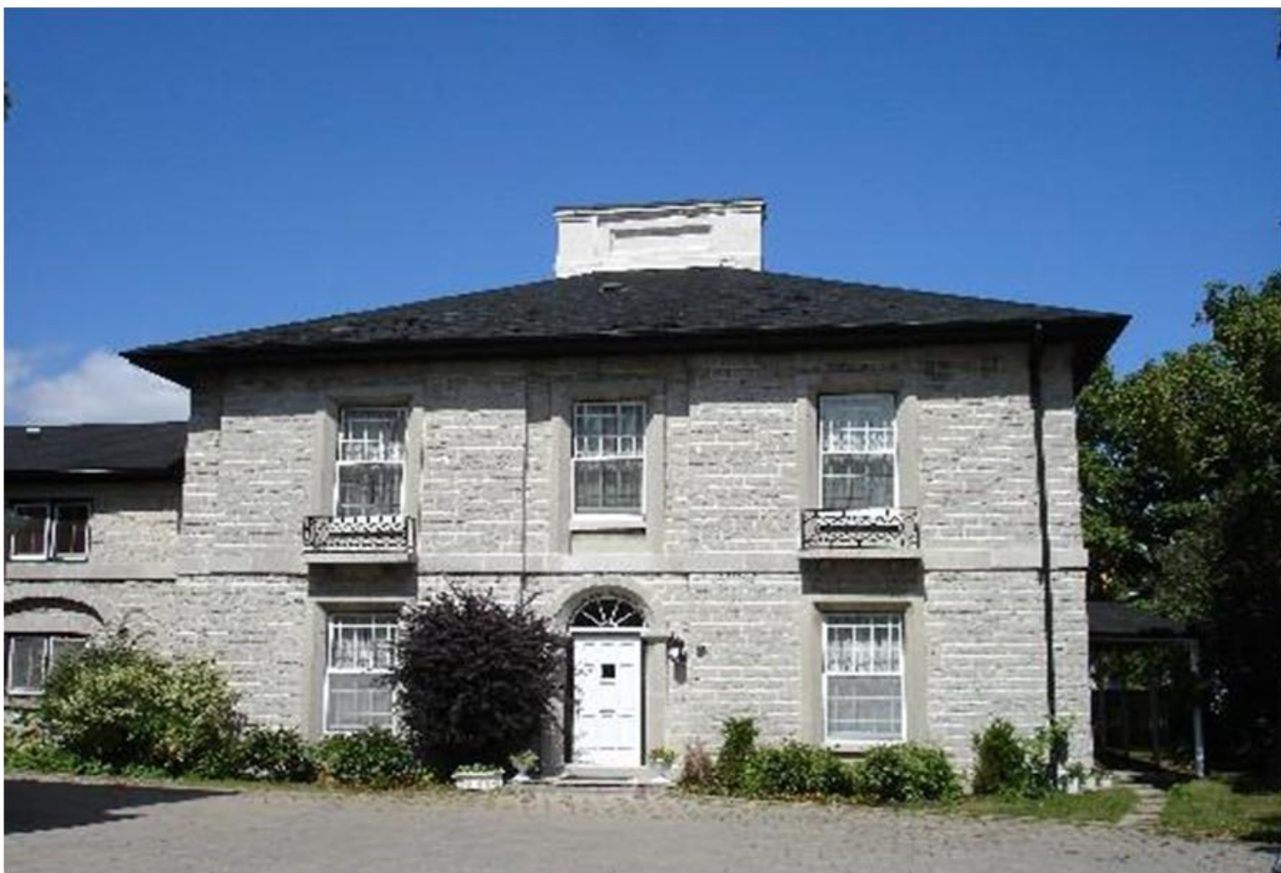
72 Le presbytère Saint Andrew, 146, rue Clergy, Kingston, Ontario. Construction en 1841-1842; George Browne, architecte; revêtement: pierre.
