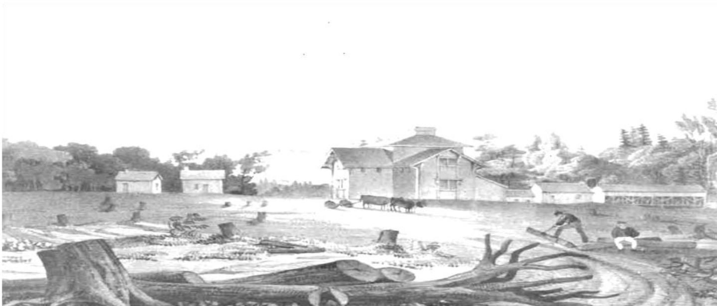
119 Stanley Tavern en 1835, Stanley, Nouveau-Brunswick; Construction en 1835 (démolie); revêtement: rondin; lithographie de S. Russell d'après un croquis de P. Harry, 1835.
