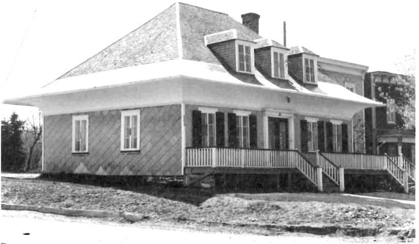
103 Cottage; 118, rue Saint-Georges ouest, Lévis, Québec. Revêtement: bois.
