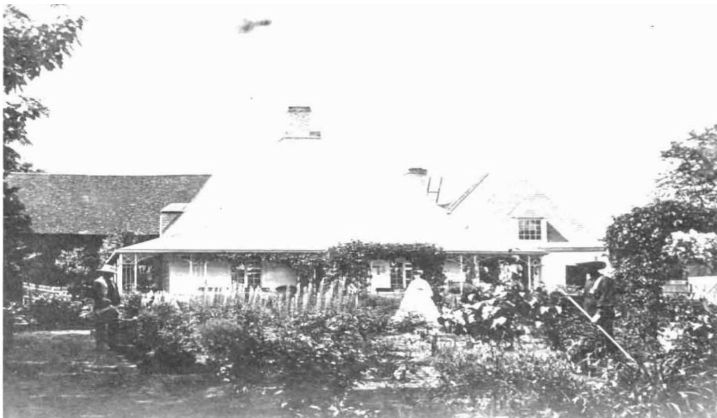
85 Rosewood Cottage en 1865, faubourg Saint-Louis, Québec, Québec Construction probablement en 1827 (démoli); revêtement: bois.
