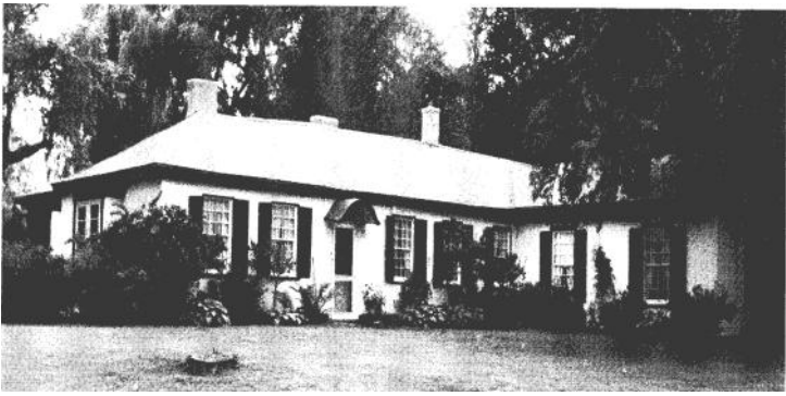
20 Le Wilderness 407, rue King, Niagara-on-the-Lake, Ontario. Construction en 1816-1817; revêtement: stuc.
