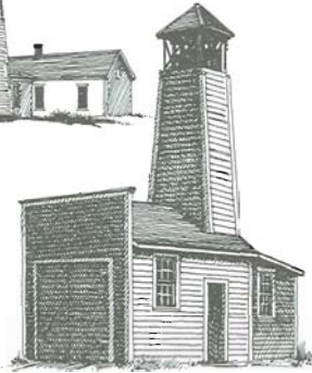
Cette tour en planches, pour sécher les boyaux d'incendie, couronne une caserne de pompiers.
